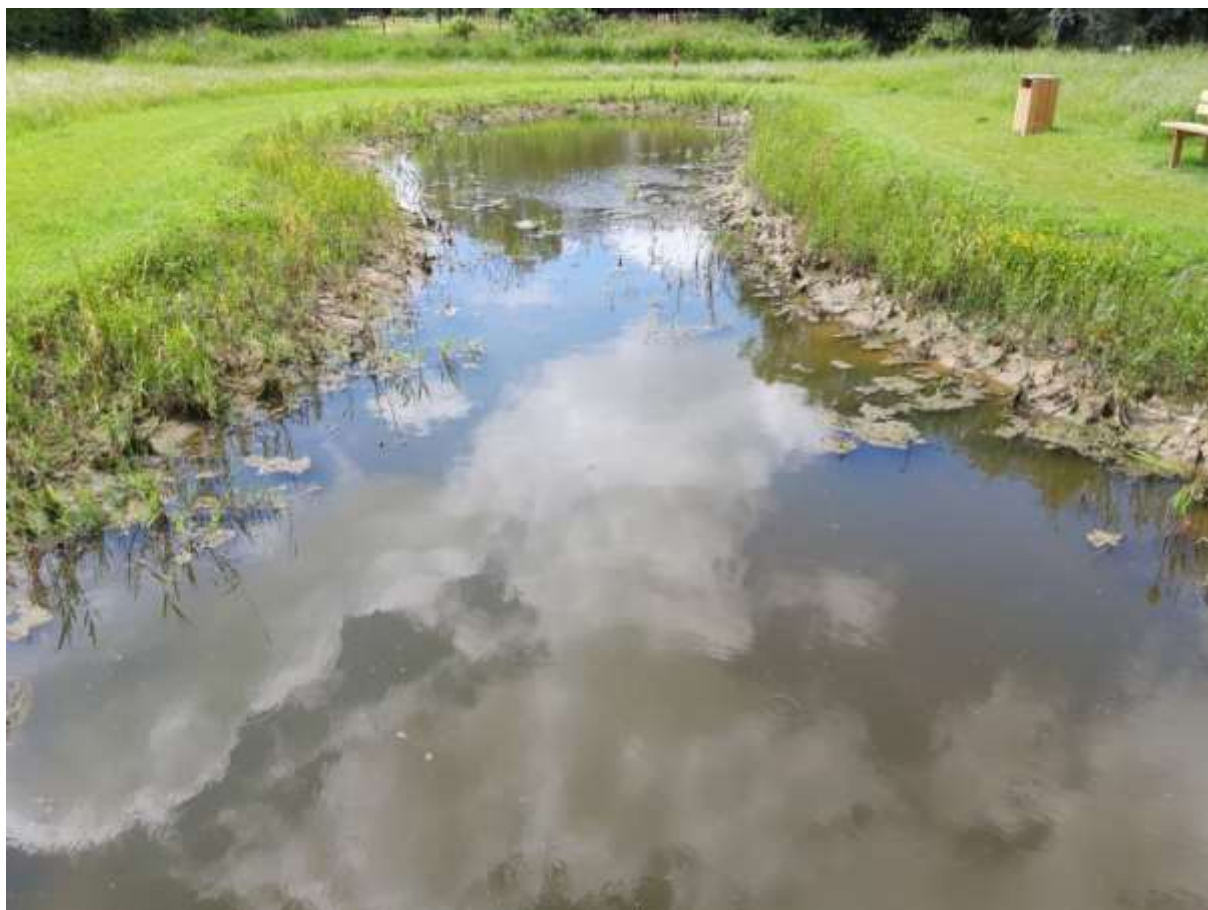
Exemple de projet similaire : mare sur terrain public à l'entrée de Noville-les-Bois, réalisée sans étanchéité
